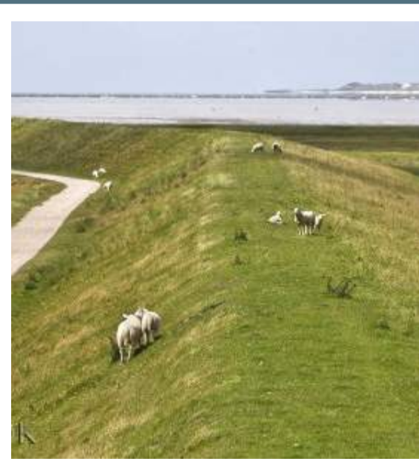
Klima - Dige - Helt tæt på vand
